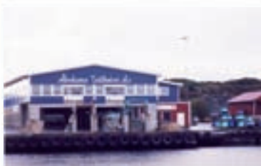
Anlegget til Åkrehamn trålbøteri sett fra sjøsiden.
