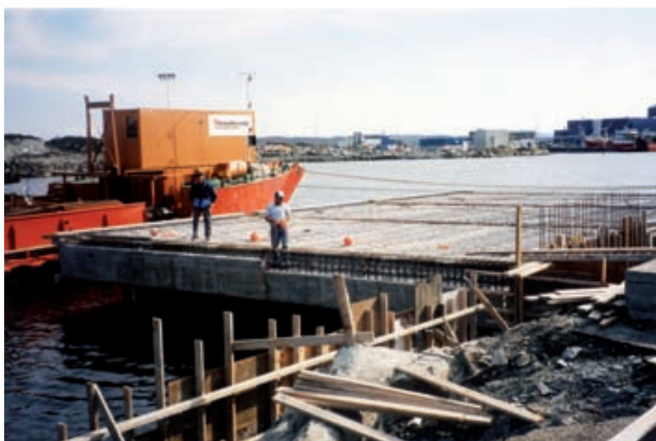
Kaianlegget under bygging i 1995
