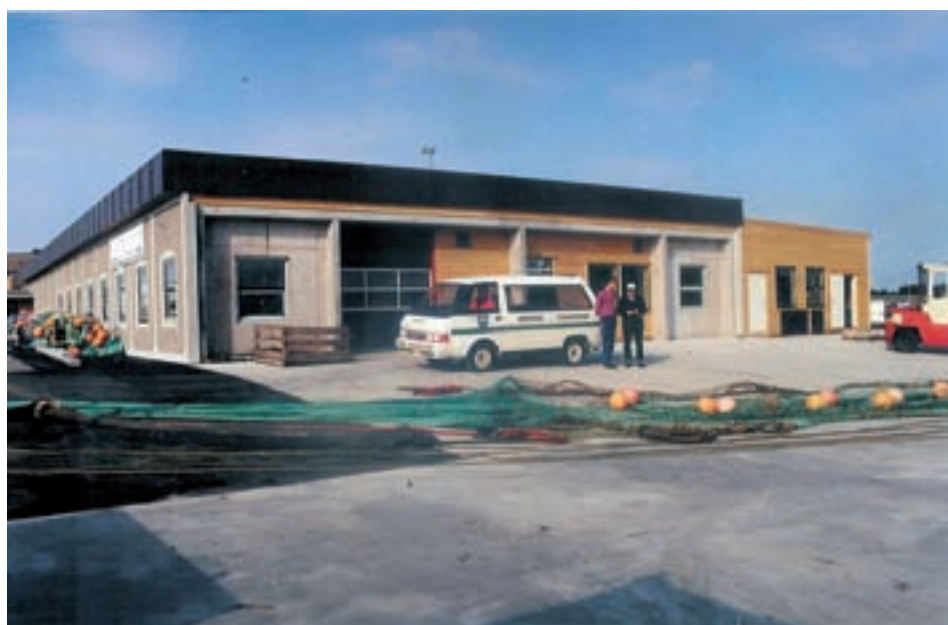
Hovedbygget på Husøy- 1. byggetrinn Einar Tangjerd AS stod for bygge arbeidet. De ferdigstøpte betongelementene ble levert av Block Berge Bygg AS. Kaien ble bygget av Veidekke AS
