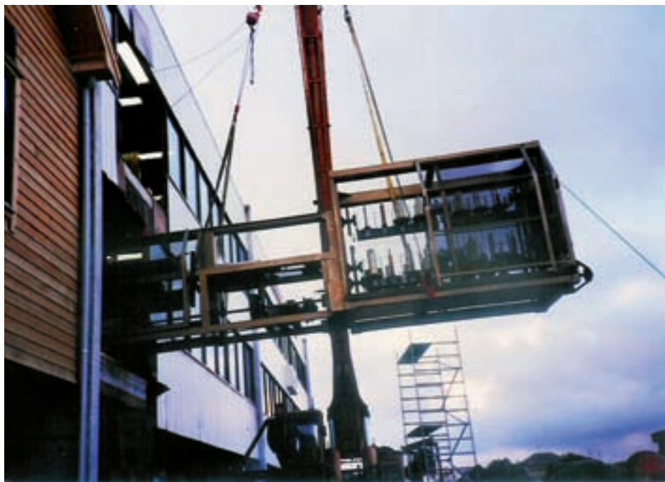
Roblon maskin flyttes fra 2. til 3. etasje
