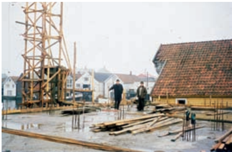
Olav Hemnes og arkitekt Egil Levik er på inspeksjon i nybyggets 2. etg. I bakgrunnen Bård Hauges sjøhus.
